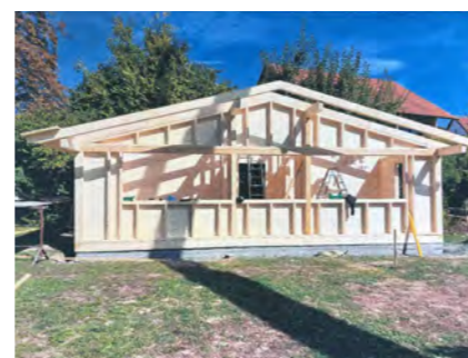
◆ Der Rohbau steht.
