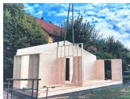
◆ Aufstellen der Innenwände
